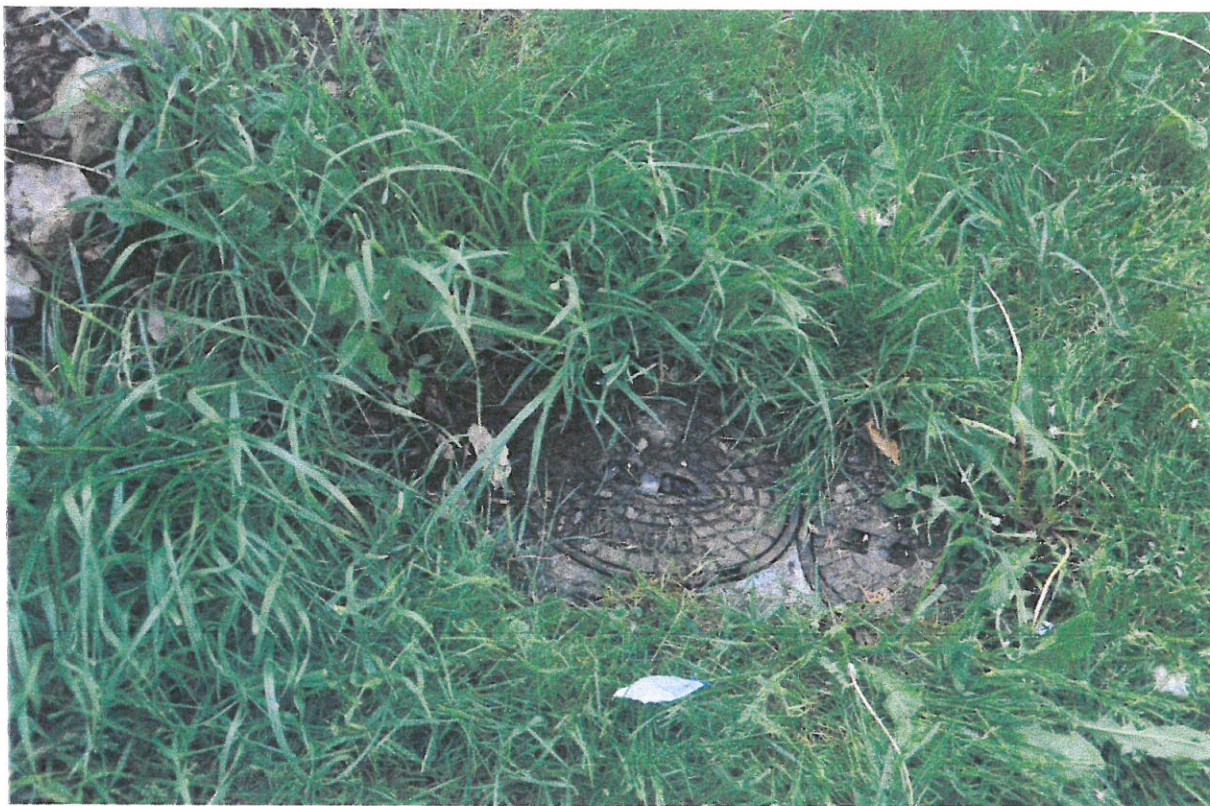
FOT.8,9. Hydrant zewnętrzny w odległości 35 m od budynku przy sąsiedniej posesji na sieci miejskiej, podziemny kwalifikowany do wymiany na nadziemny.
