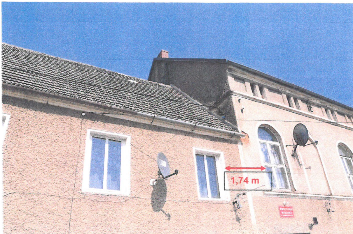
FOT. Nr 6. Odległość otworów w budynku objętego opracowaniem od sąsiedniego kwalifikowanego do kategorii zagrożenia ludzi ZLIV.
