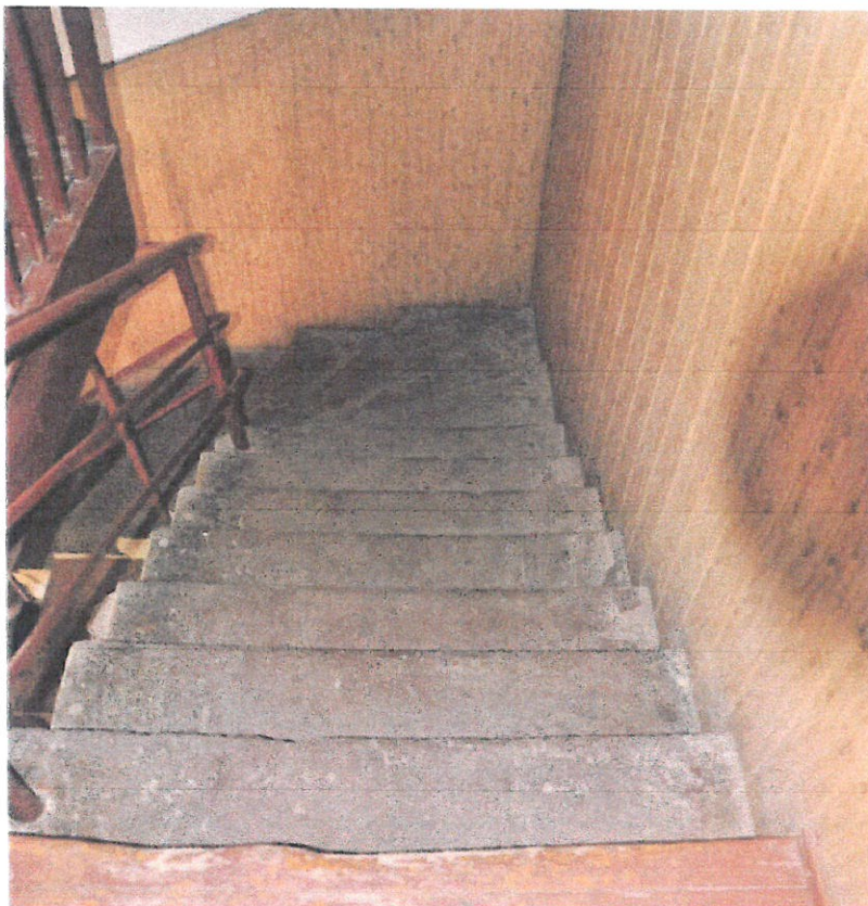
FOT.7. Konstrukcja schodów i widok klatki schodowej przed przebudową.
