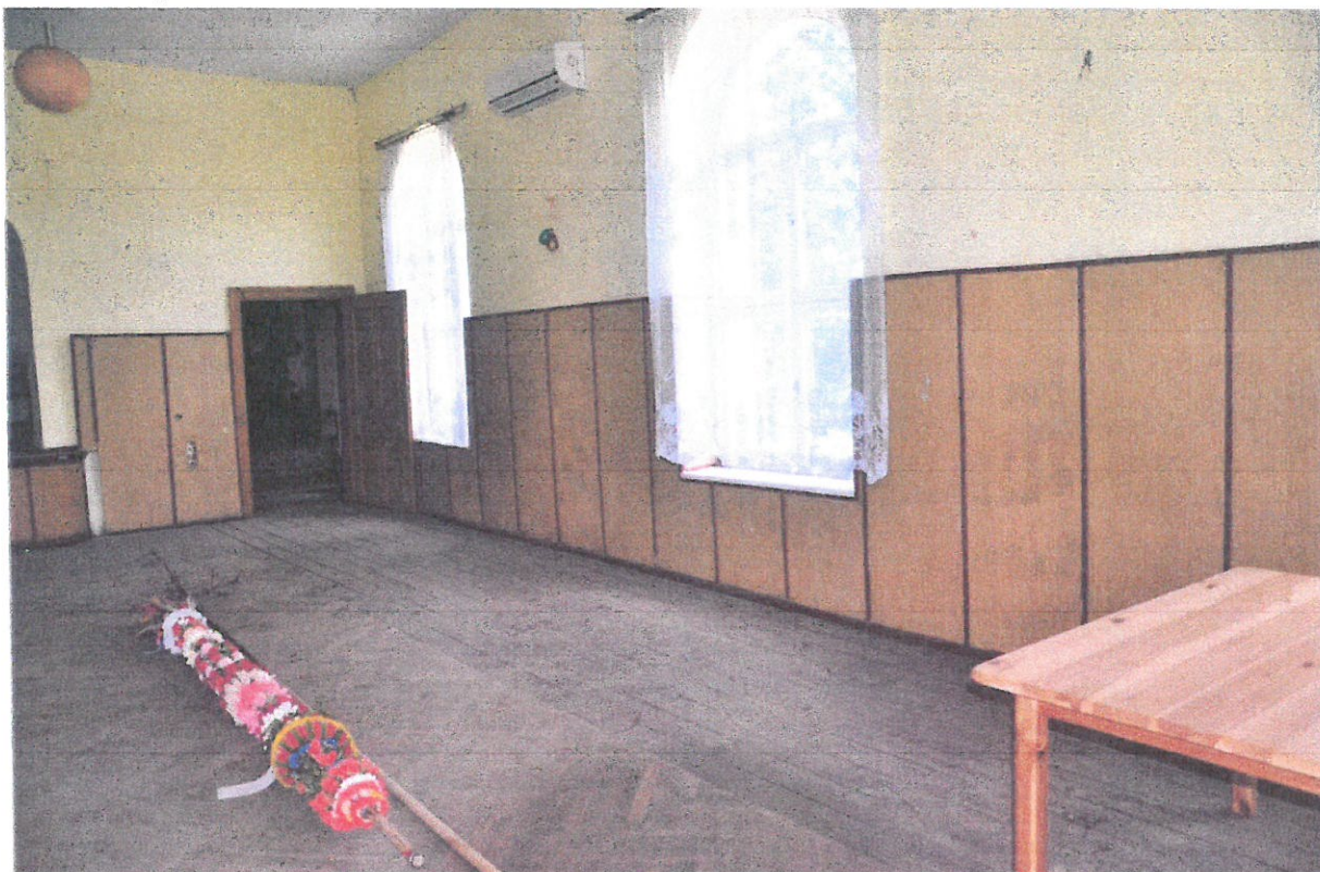
Fot. 4. Boazeria świetlicy do rozbiórki, okna do wymiany.
