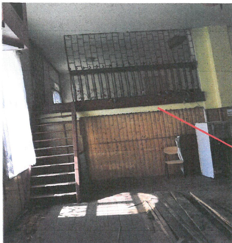
Fot. 2. Pomieszczenie gospodarcze – kuchnia ze stropem do rozbiórki oraz obudową z boazerii do likwidacji.
