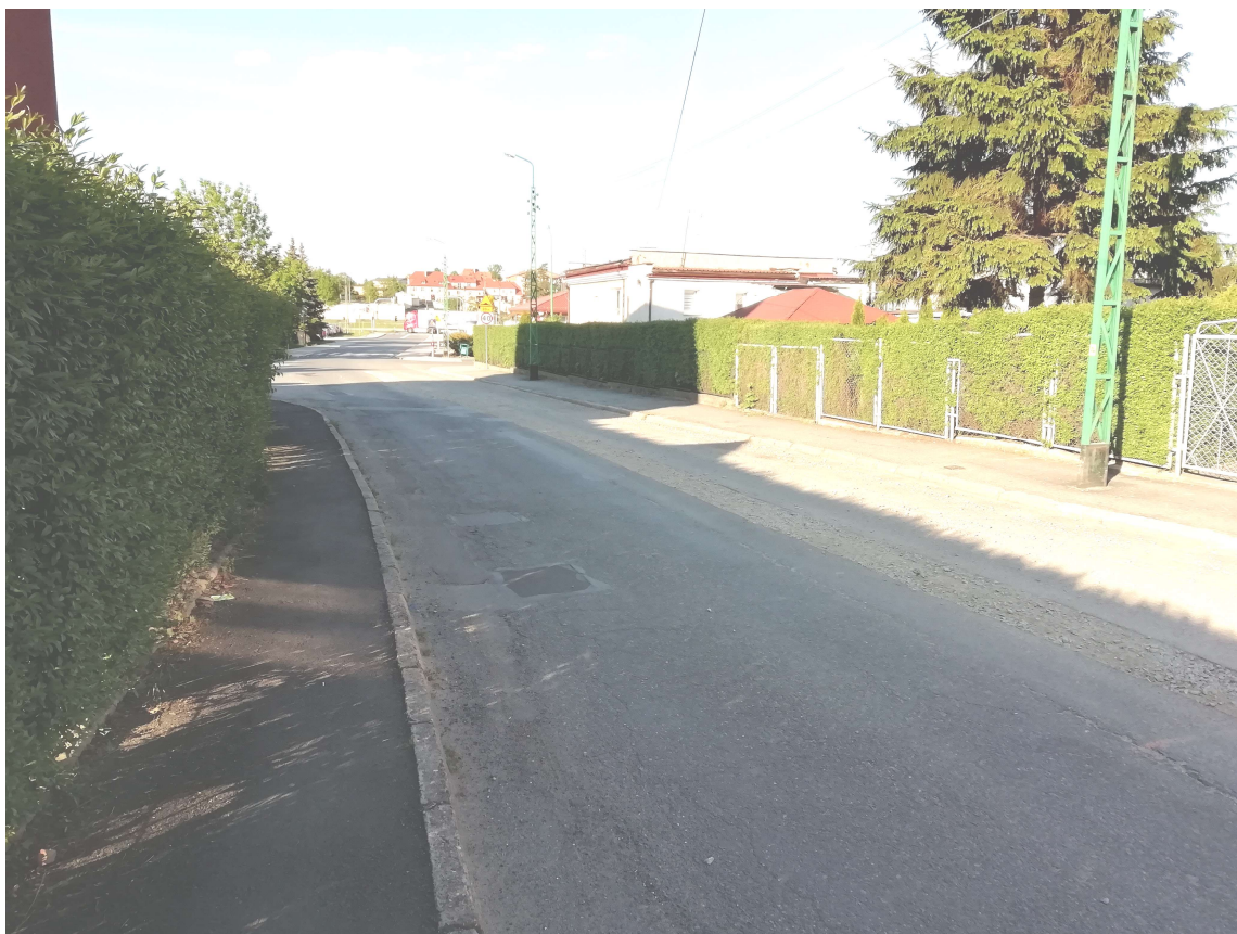
Zdjęcie nr 3. Odcinek końcowy.
