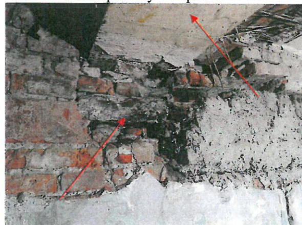
FOTO 31 Uszkodzone cegły pod podciągami stalowymi nr 3 z dwuteowników 3xNP 260
