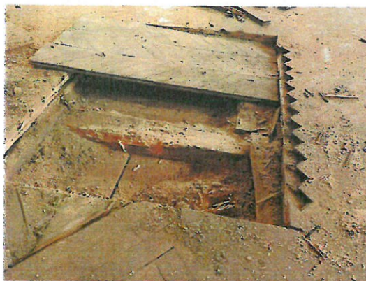
FOTO 18 Odkrywka stropu sala świetlicy
