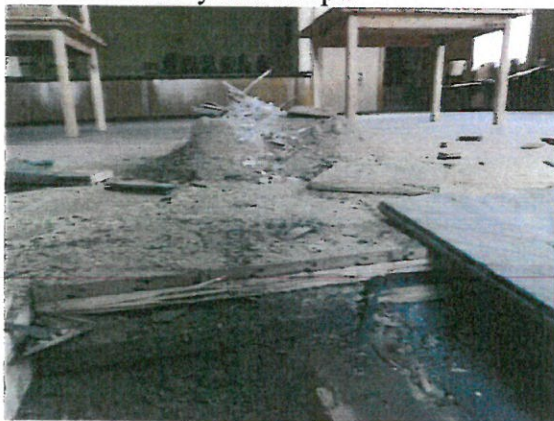
FOTO 19 Odkrywka stropu sala świetlicy podwójna podłoga
