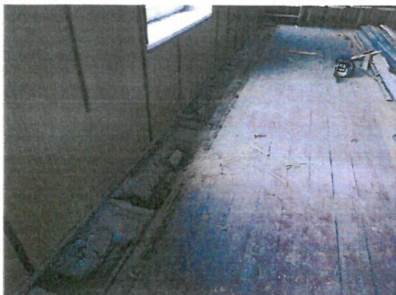
FOTO 9 Odkrywka belek stropowych wzdłuż okien elewacji frontowej sali świetlicy
