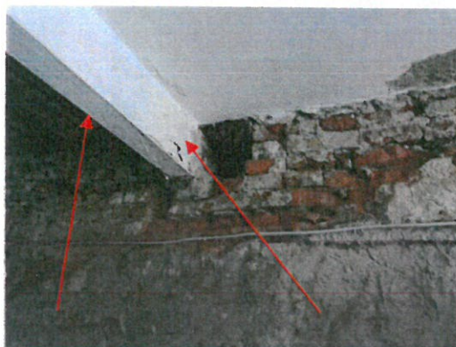
FOTO 22 Widok wyciętego podciagu i podparcie belek stropowych dwuteownikiem I260
