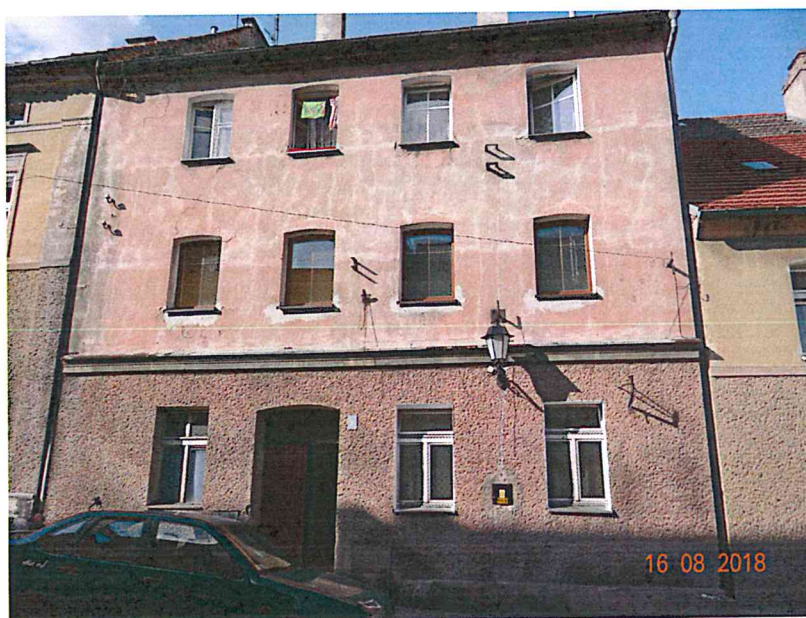
Fotografia nr 1 Elewacja frontowa budynku
