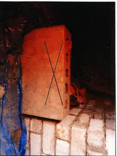
× nie podłączony KOMIN K4 5x(14x14) na strychu przewody nieużytkowane
