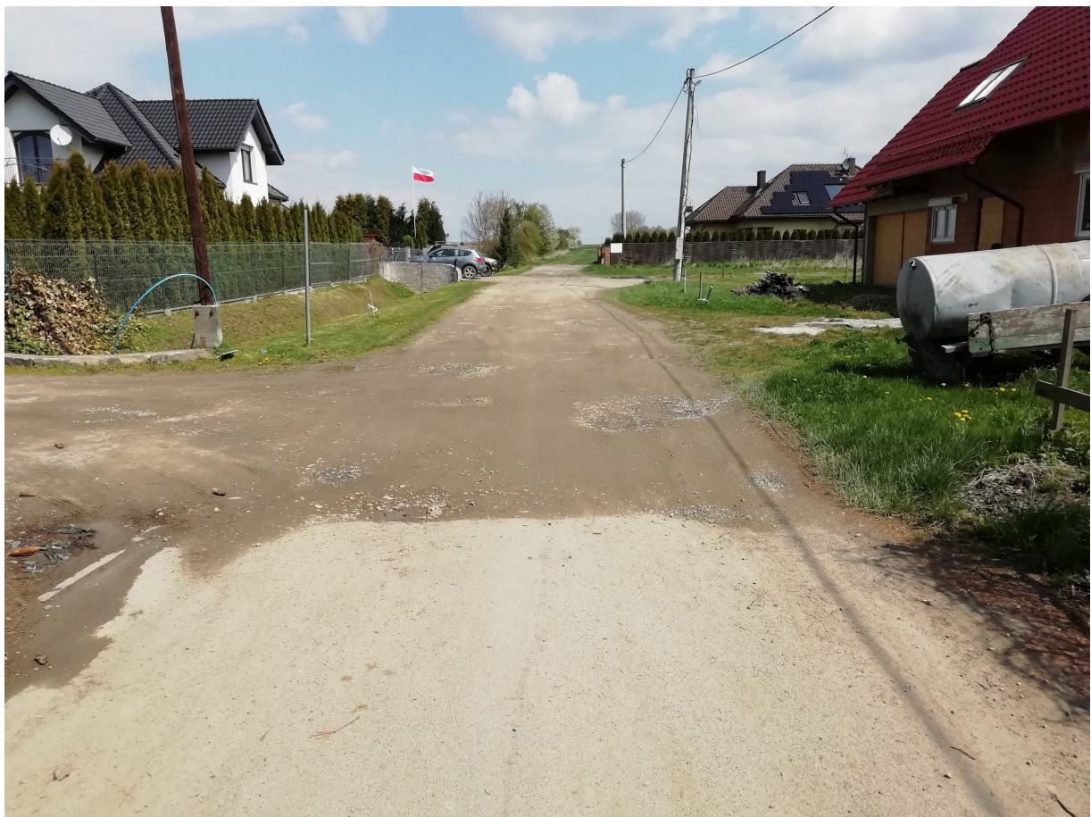
Zdjęcie nr 3. Odcinek końcowy.
