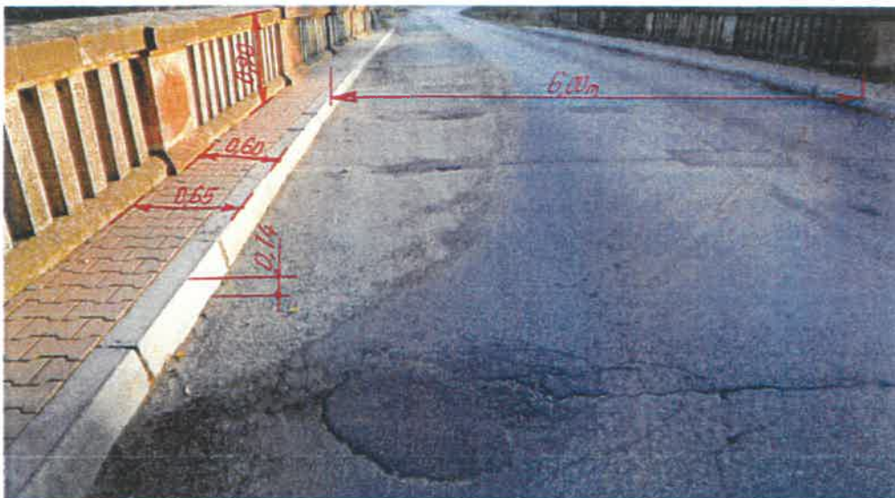
rys. 4 – chodnik przy balustradzie od strony dolnej wody
