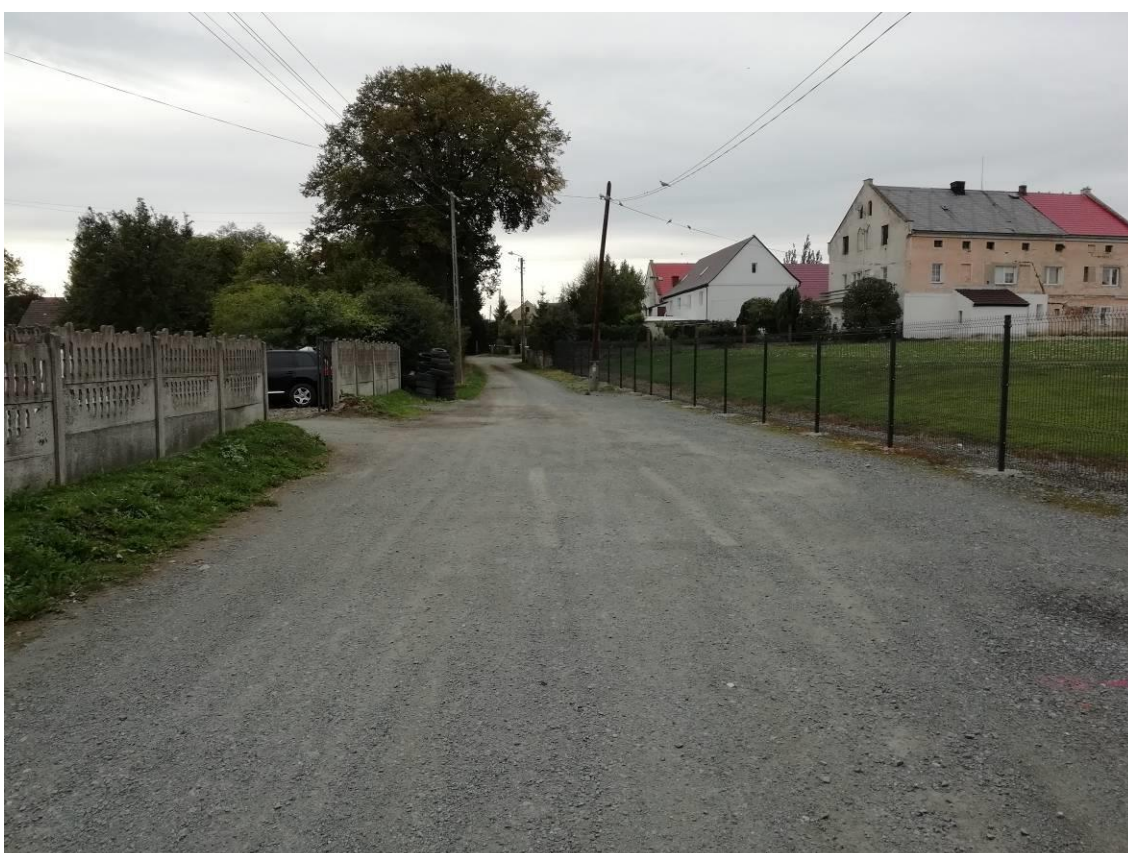
Zdjęcie nr 2. Odcinek środkowy - km 0+100,00.
