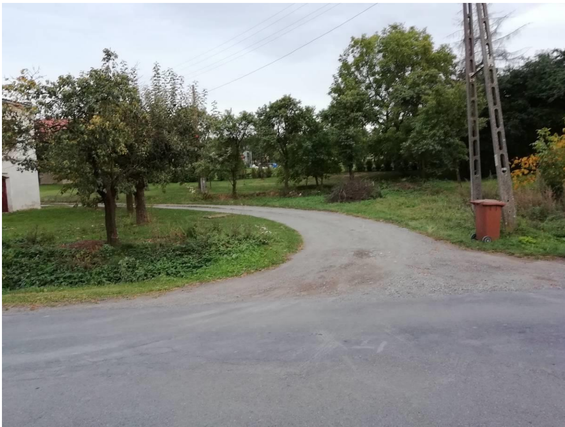
Zdjęcie nr 1. Odcinek początkowy - połączenie z drogą powiatową nr 3158D.
