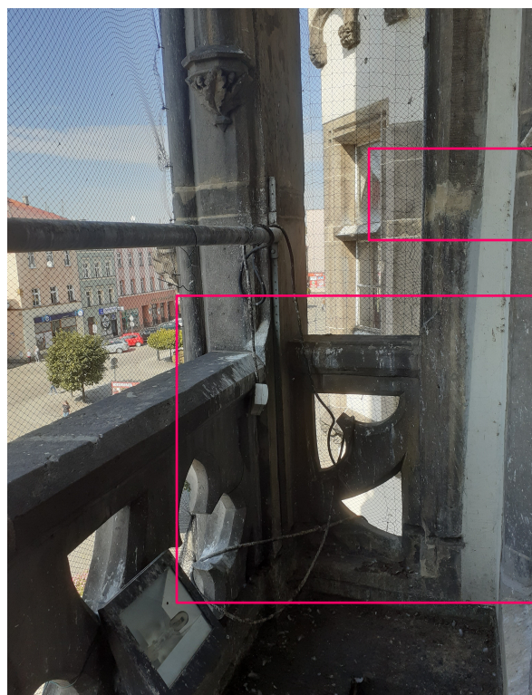
Fot 8 Wykusze wnętrza balustrady i wimpergi zanieczyszczone gąsienicami
