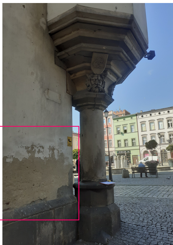
Fot 12 Niewłaściwie uzupełniany tynk zaprawa piaskowo cementowa
