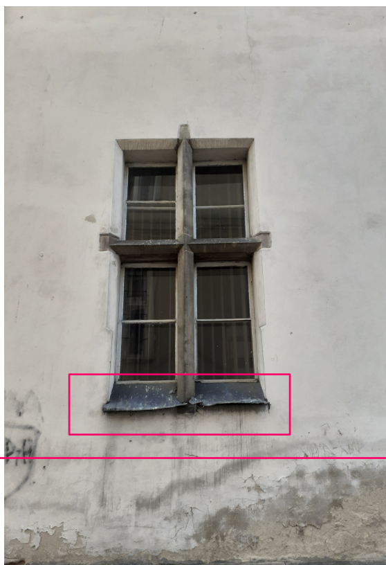
Fot 11 Wysolenia tynku i uszkodzony parapet z blachy ocynkowanej
