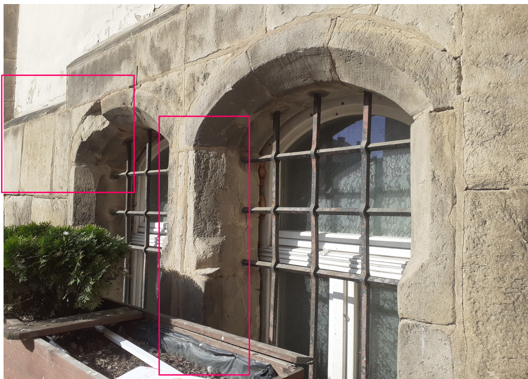
Fot 1. Okna przyziemia widoczne uszkodzone fasety – ubytek w nadprożu, oraz niewłaściwy kształt fasety po próbie rekonstrukcji
