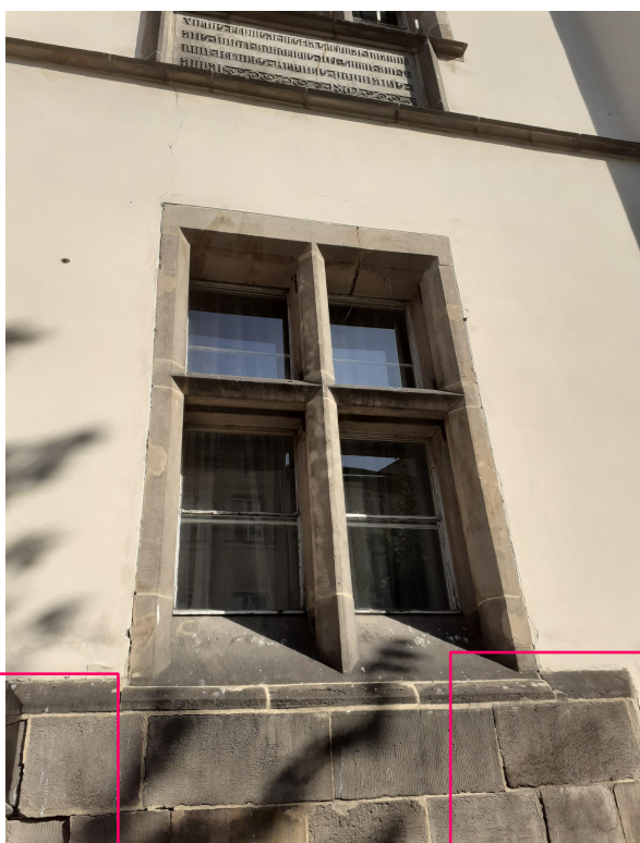
Fot 5. Odspojone bloki kamienne
