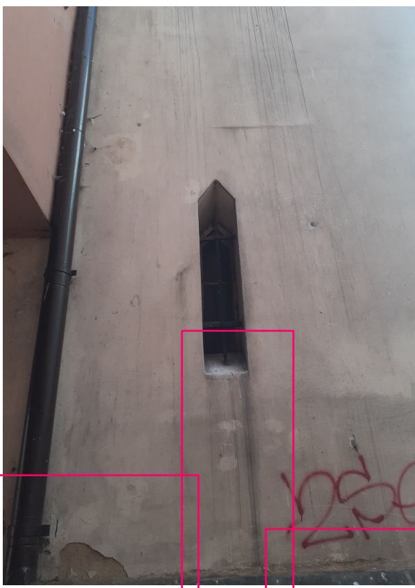
Fot 9 Łuszczący się tynk. Brak parapetu powodujący zanieczyszczenie dolnej partii
