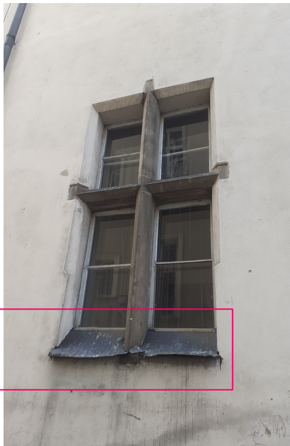
Fot.13 Otwór okienny ze stolarką bezramową Fot. 14 Parapet stalowy ocynkowany widoczne nieskuteczne próby uszczelnienia zdeformowany
