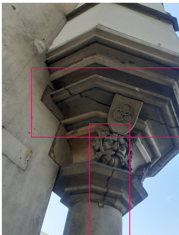
Fot 7. Pęknięcie kapitelu kolumny wspierającej basztę.
