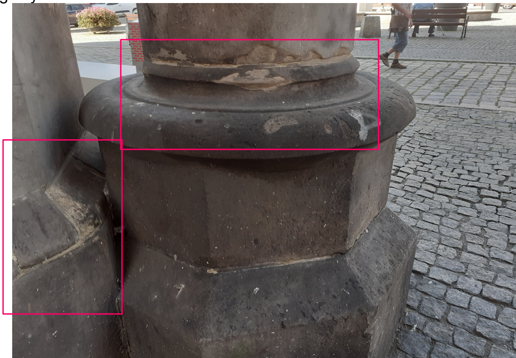
Fot.2 Baza kolumny wspierająca wykusz. Widoczna erozja elementów piaskowca i niewłaściwie łączone elementy cokolu
