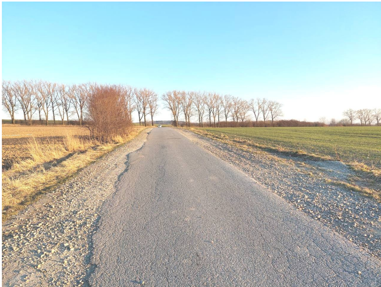
Zdjęcie nr 1. Widok w kierunku drogi powiatowej nr 3174D.
