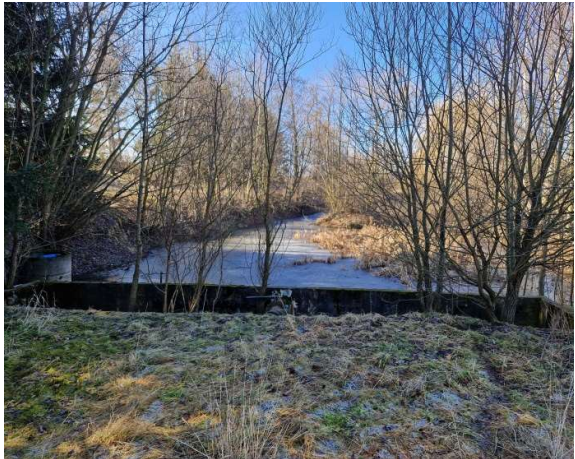
Zbiornik retencyjny wód opadowych
