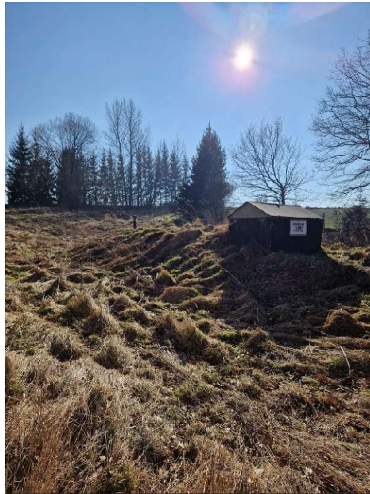
Zbiornik wody czystej
