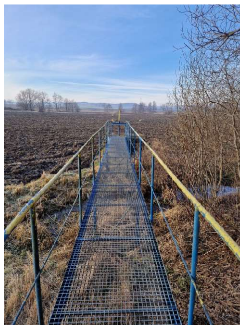
Kładka do przelewu burzowego
