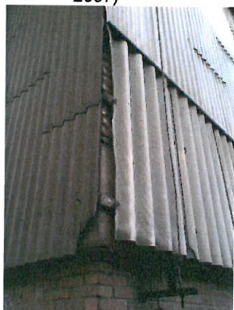
Elewacja z płyty falistej, płyty azbestowo-cementowej (Ministerstwo Gospodarki, 2007)
