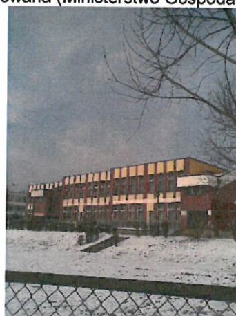
Elewacja z płyty azbestowo-cementowej płaskiej, malowana (Ministerstwo Gospodarki, 2007)
