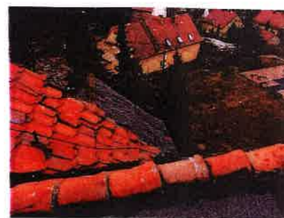
FOTO 7, 8, 9 STAN TECHNICZNY POKRYCIA Z DACHÓWKI karpíówki podwójnie w koronkę
