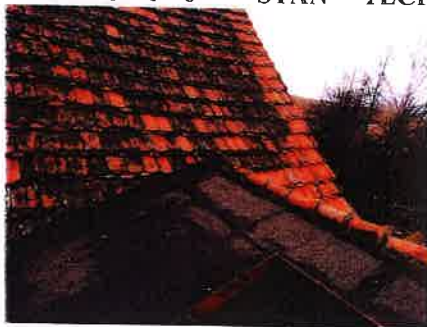
FOTO 7, 8, 9 STAN TECHNICZNY POKRYCIA Z DACHÓWKI karpíówki podwójnie w koronkę
