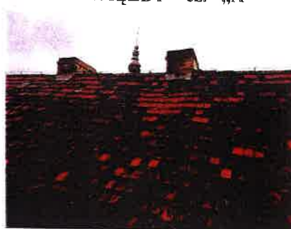
FOTO 7, 8, 9 STAN TECHNICZNY POKRYCIA Z DACHÓWKI karpíówki podwójnie w koronkę
