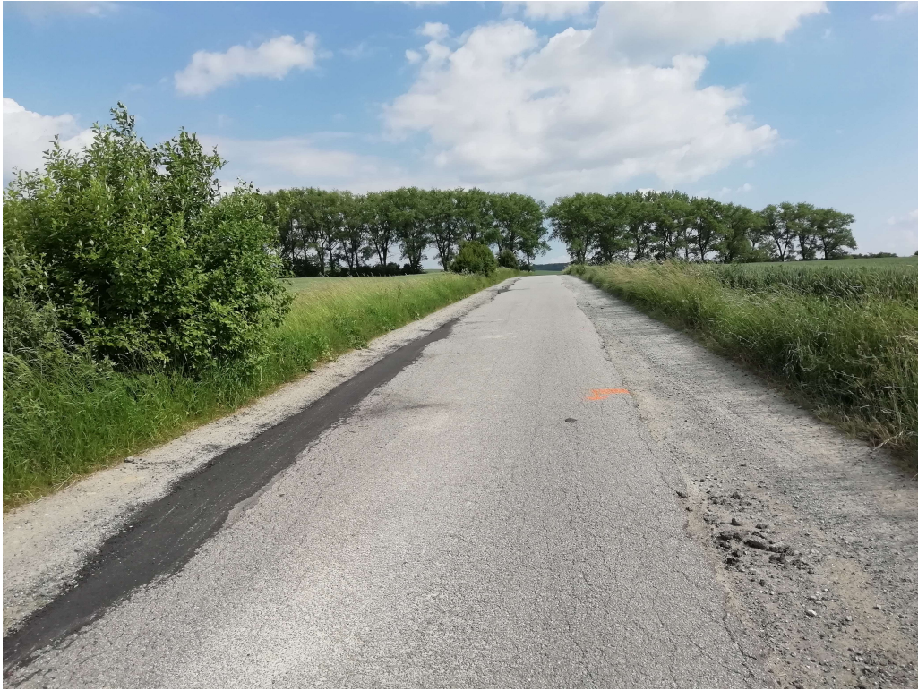
Zdjęcie nr 3. Odcinek końcowy
