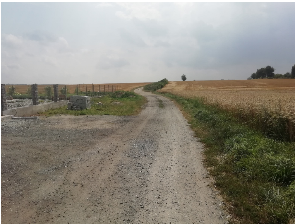
Zdjęcie nr 3. Odcinek końcowy
